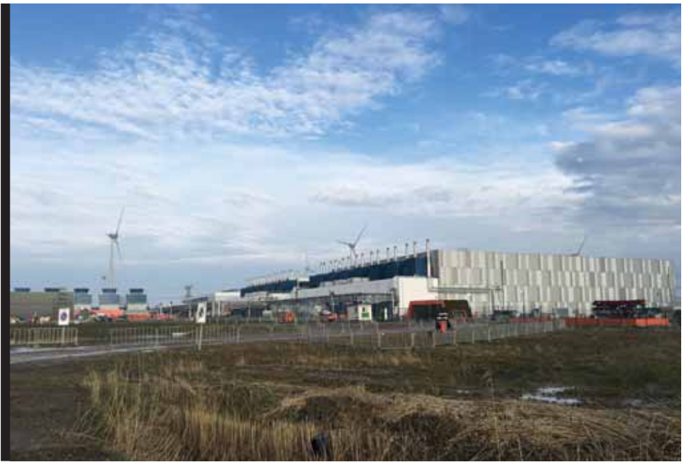
Het datacentrum van Google in de Eemshaven
